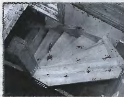
Изготовление поворотного марша — наиболее сложная часть работы
