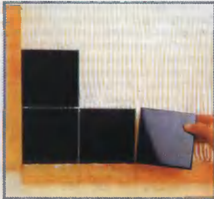
Первую плитку кладут в угол между маячными рейками, а затем выкладывают весь нижний ряд
