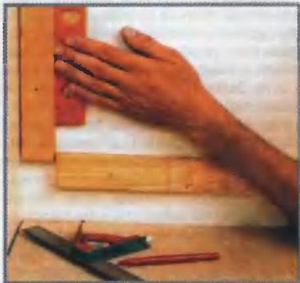
Прежде чем прикрепить вертикальную рейку, ее тщательно выверяют с помощью уровня
