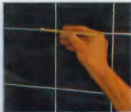
С помощью круглой деревянной палочки швы разглаживают, придавая им соответствующую форму
