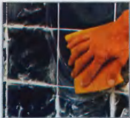
При протирке плиток влажной губкой оставшуюся на их поверхности массу втирают в швы
