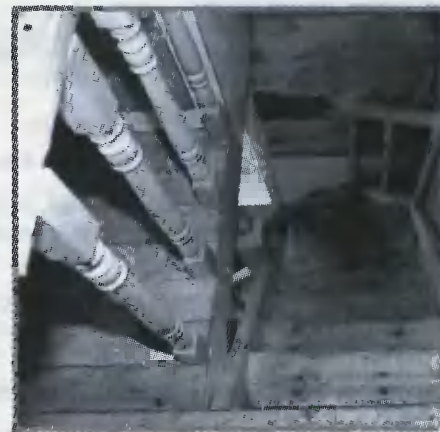
Лестница — вид сверху
