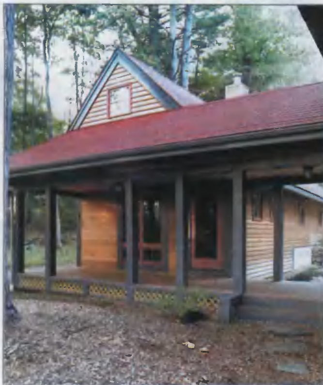
Отдельная спальня для внуков служит экраном и закрывает дом соседей слева. Крытое крыльцо-галерея ведет ко входу в основной дом. Вид по стрелке С на плане
