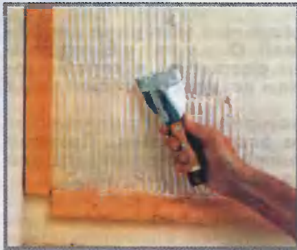
Клей наносят на участок стены площадью примерно 1 м 2 с помощью зубчатого шпателя
