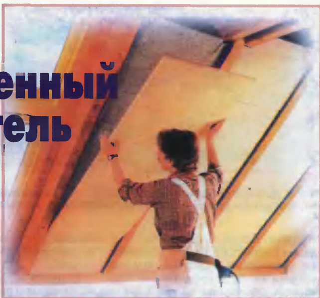
Плиты утеплителя легко и просто устанавливаются
